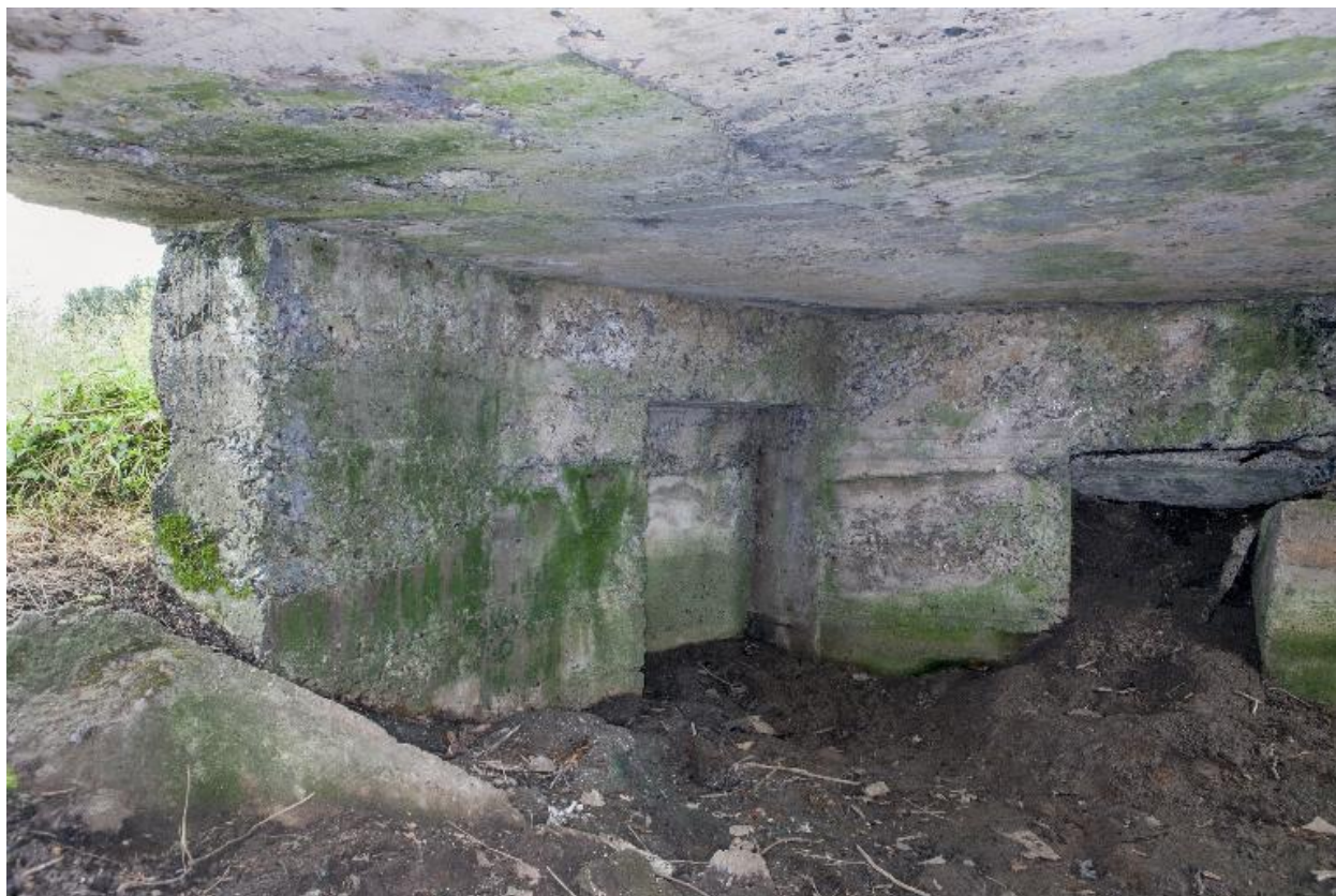
Chambre de tir, vers l'ouest
