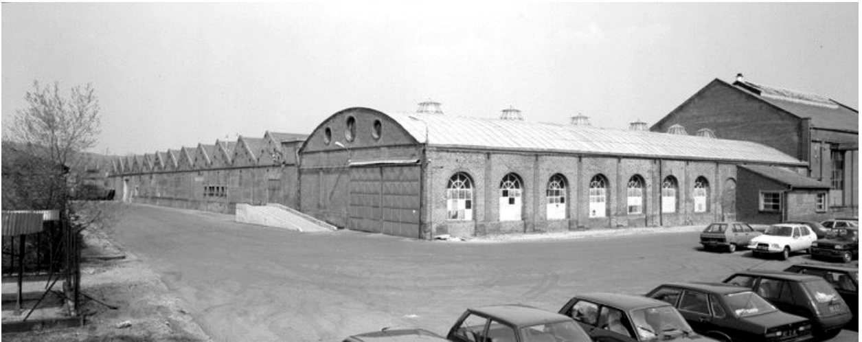
Vue générale de l'ancien atelier de pliage, état en 1988.
