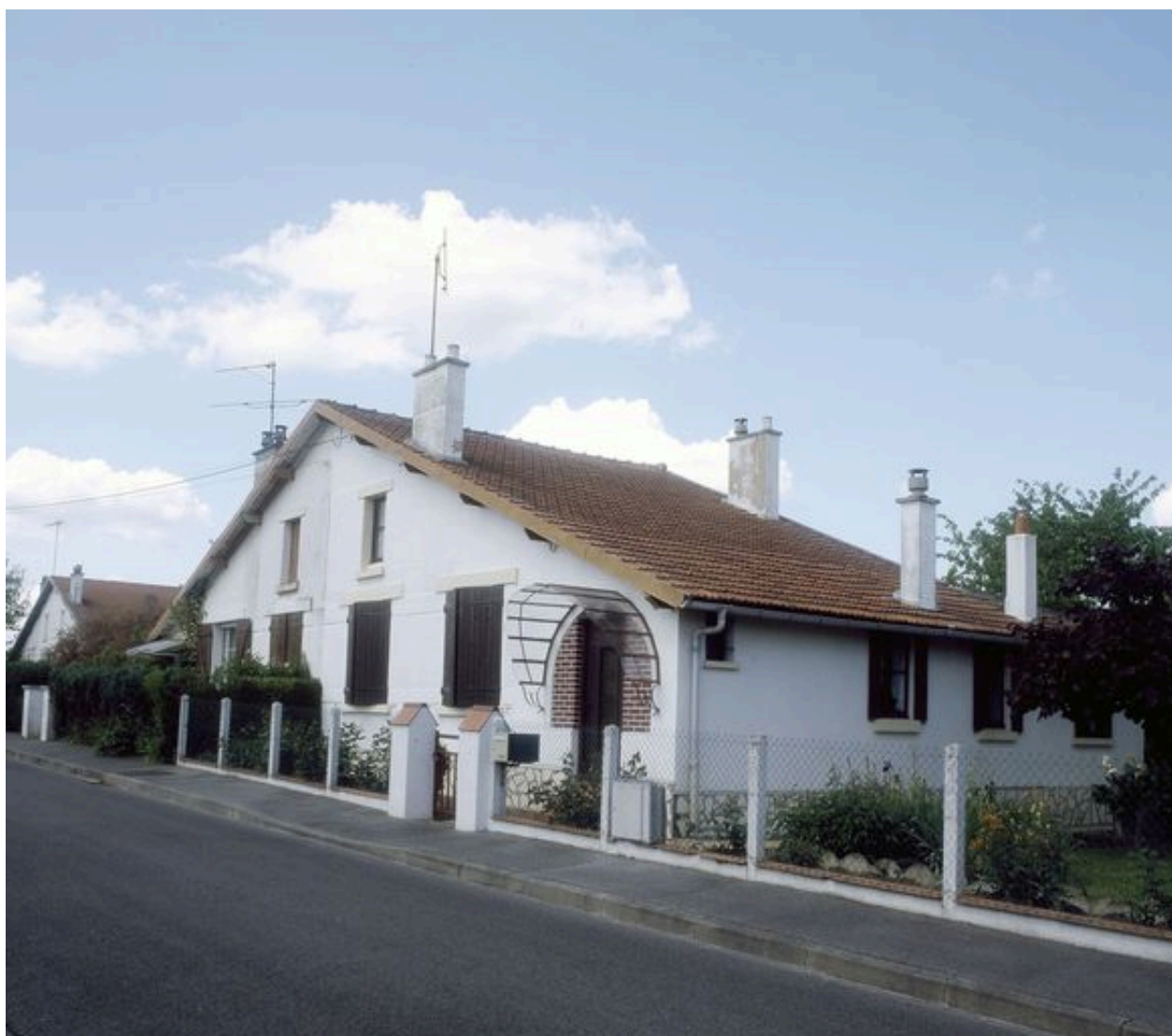
Maisons d'ouvrier en logements jumelés.
