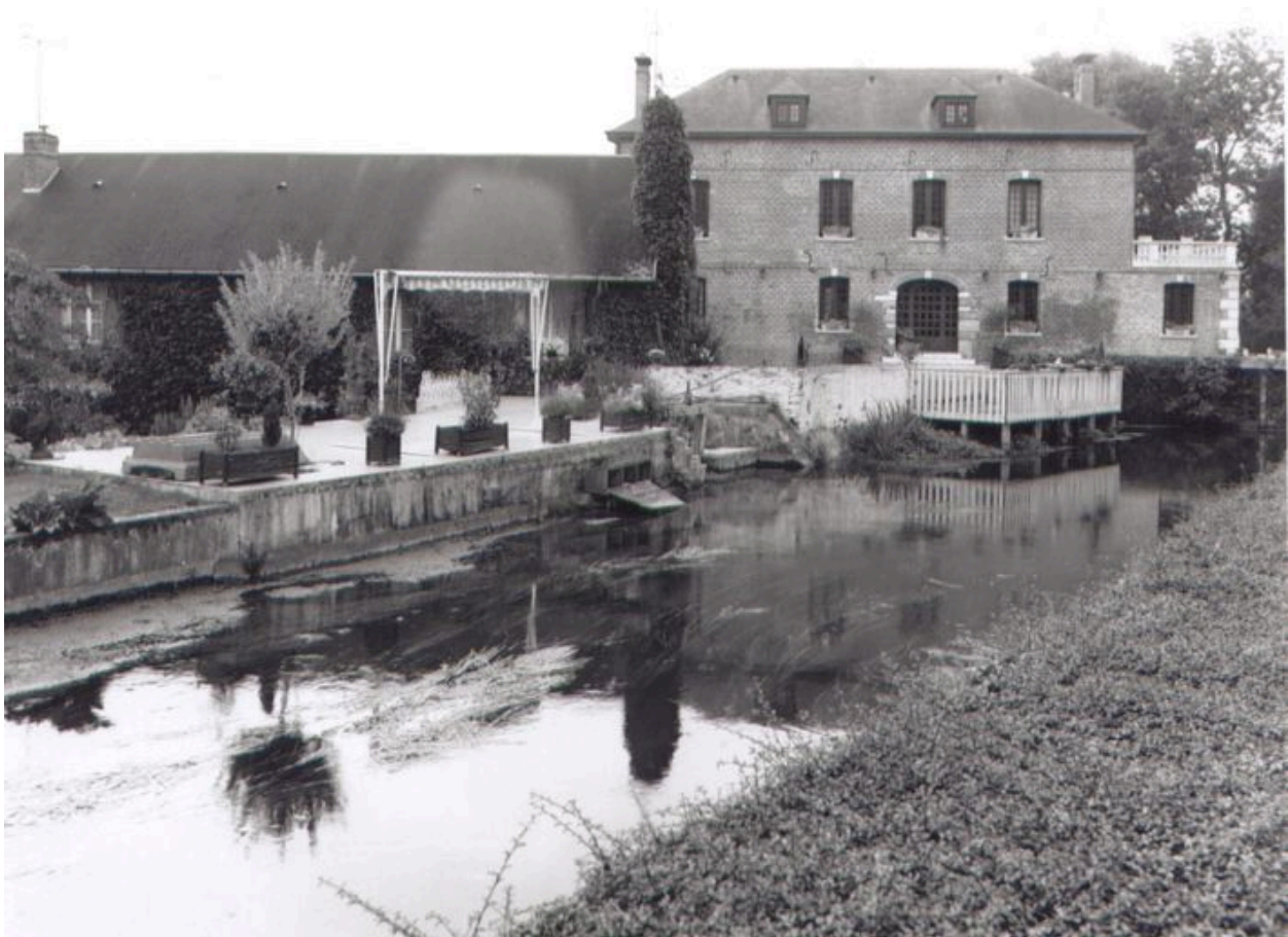
Vue d'ensemble du l'usine, côté ouest.
