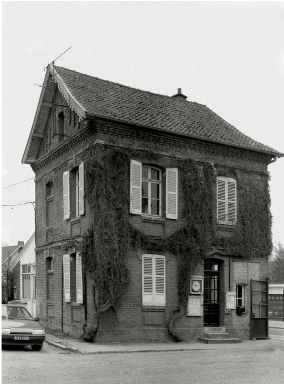
La conciergerie, vue d'ensemble sur rue, en 1988.
