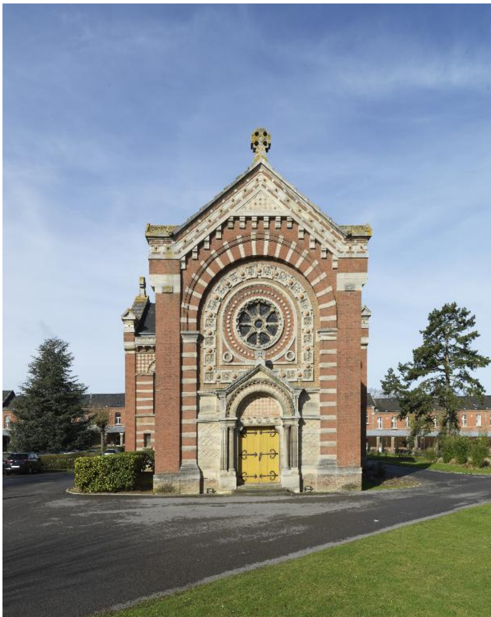
Vue de la façade est.
