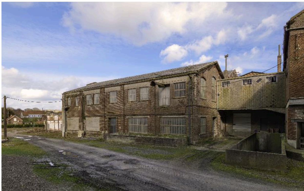
Atelier de fabrication, côté nord.
