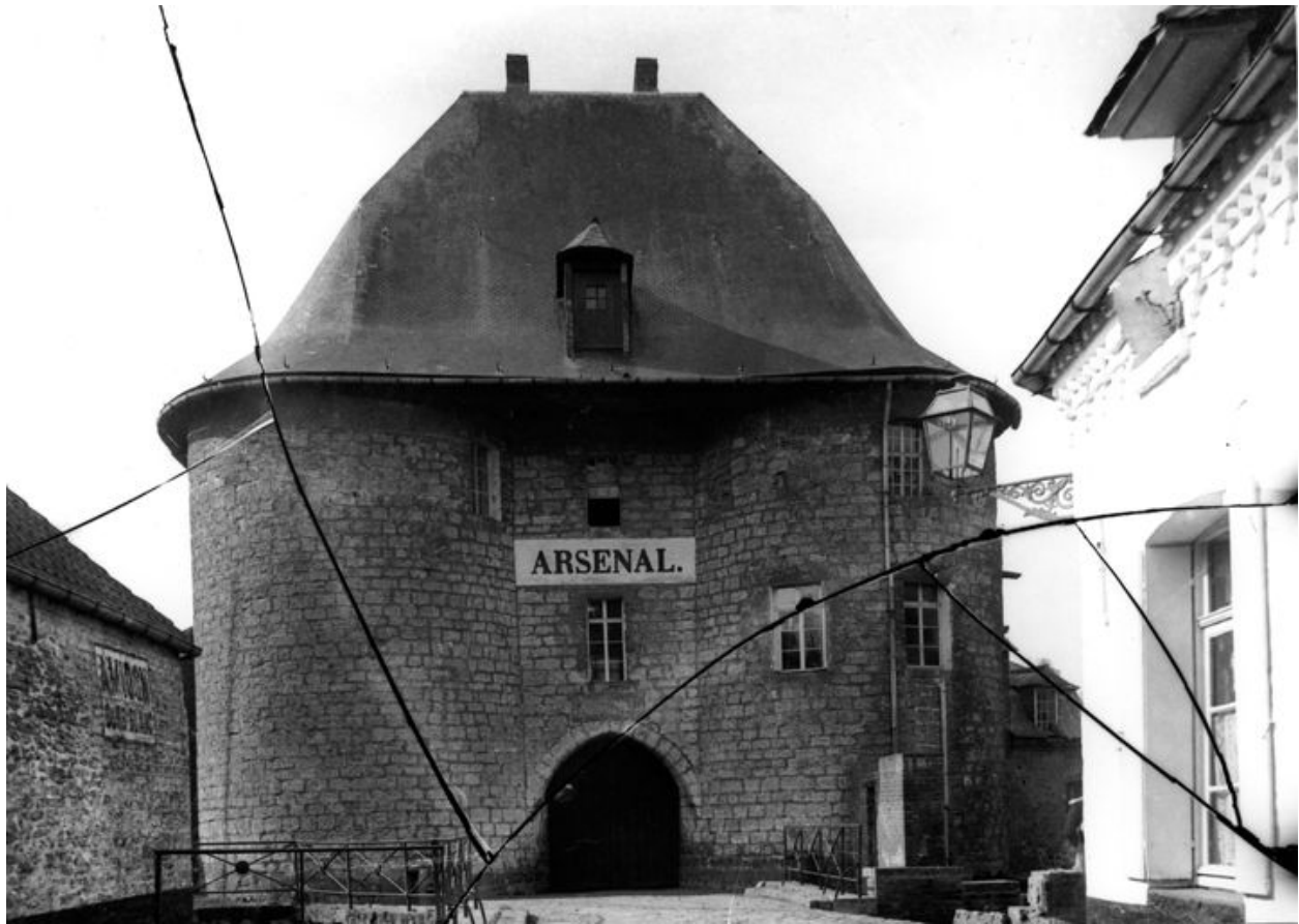
Ouvrage d'entrée, vue d'ensemble côté ville, vers 1900 (Courtine nord du château, baignée par la Haynette, vers 1900 ; au fond la tour du moulin (Douai - Musée de la Chartreuse - Photothèque Augustin Boutique-Grard).
