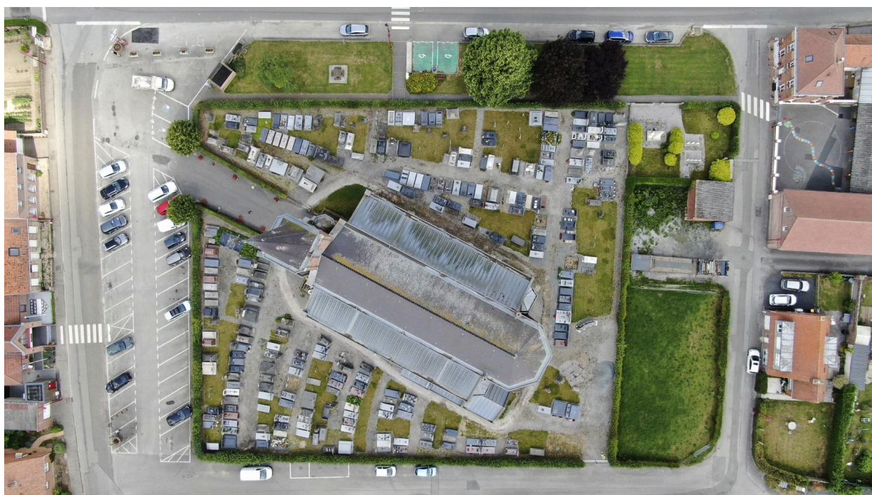
Vue zénithale de l'église.
