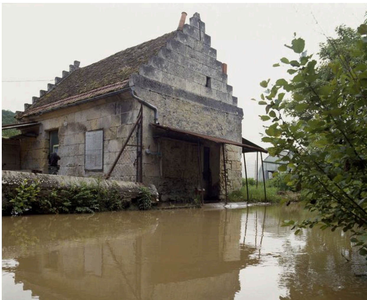
Le bassin de retenue.
