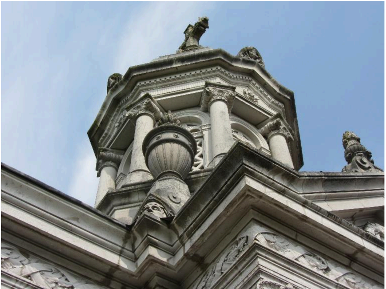
Détail des pots à feux.
