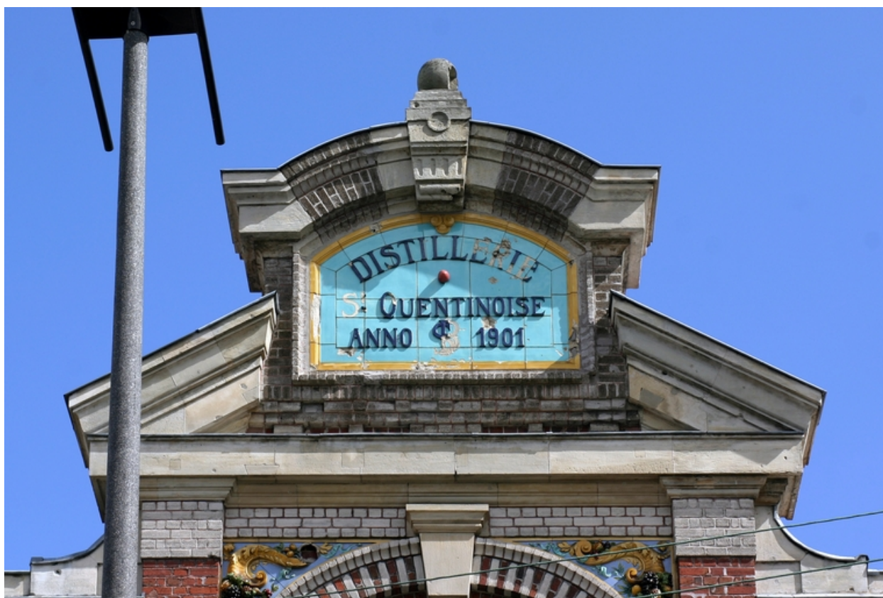
Façade antérieure, détail.
