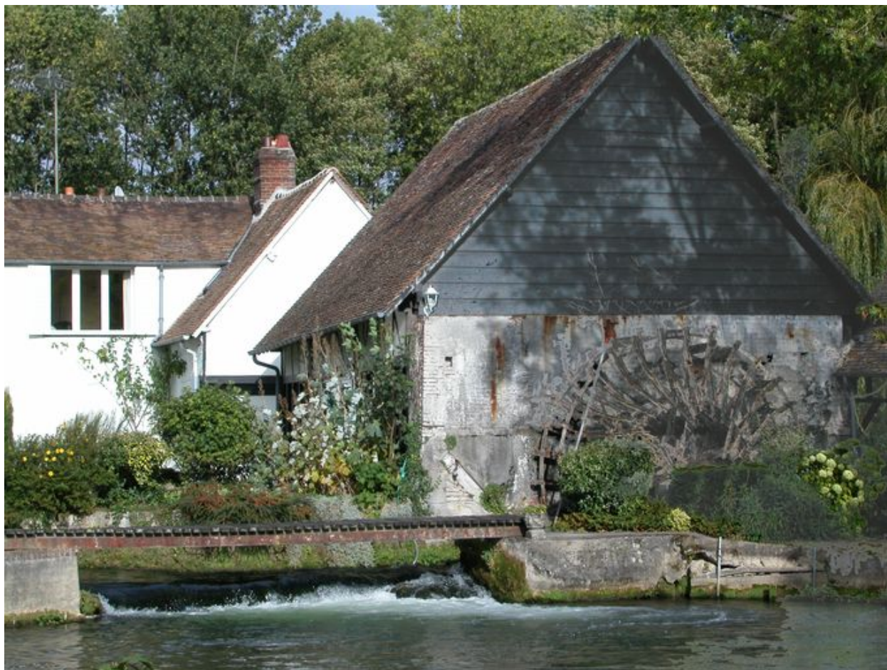
Vue du pignon du moulin hydraulique.
