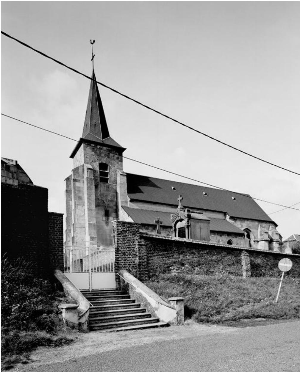
Vue d'ensemble de l'église et du cimetière, depuis le sud-ouest.
