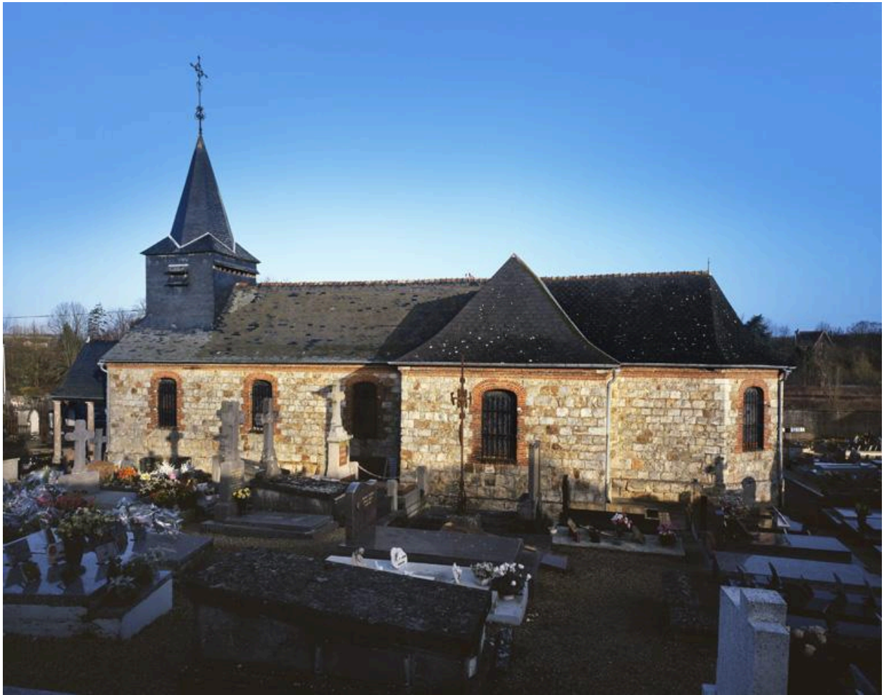
Vue de l'élévation sud.
