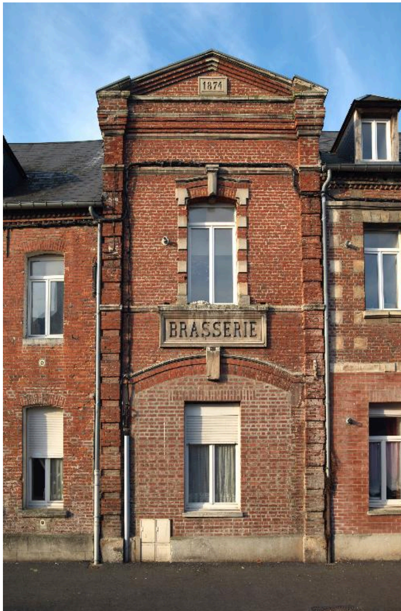
La travée centrale de l'ancienne brasserie.
