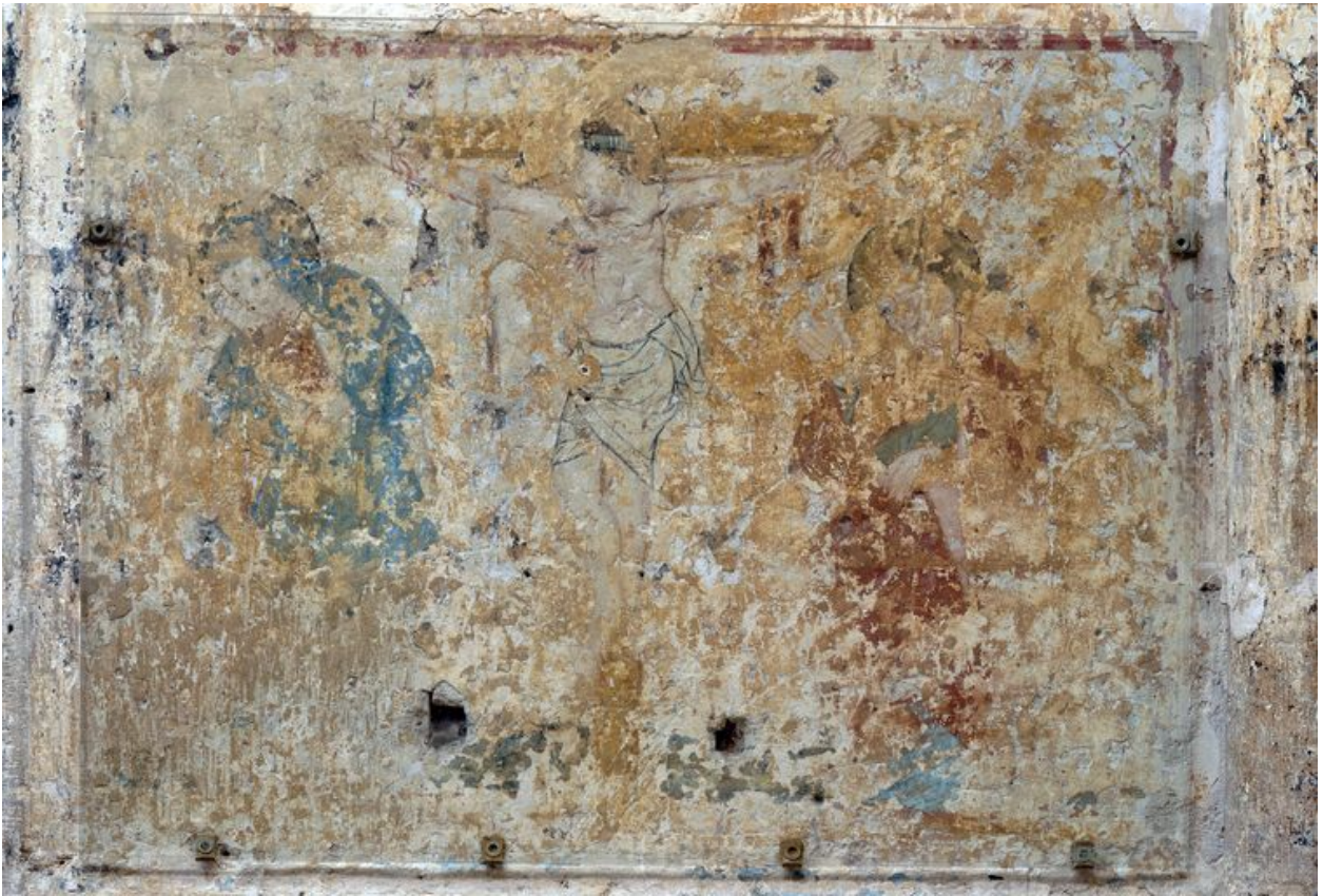
Transept, croisillon nord, mur est.
