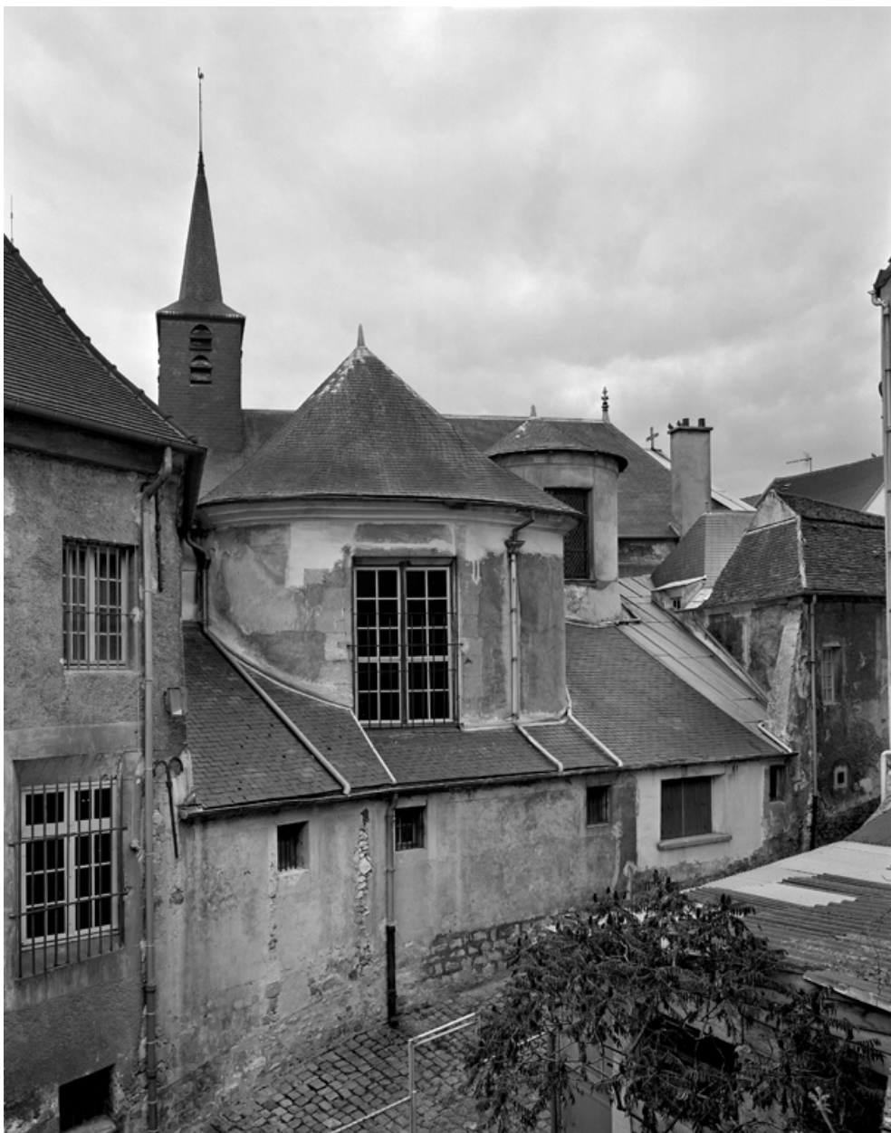
Les toitures de la chapelle.
