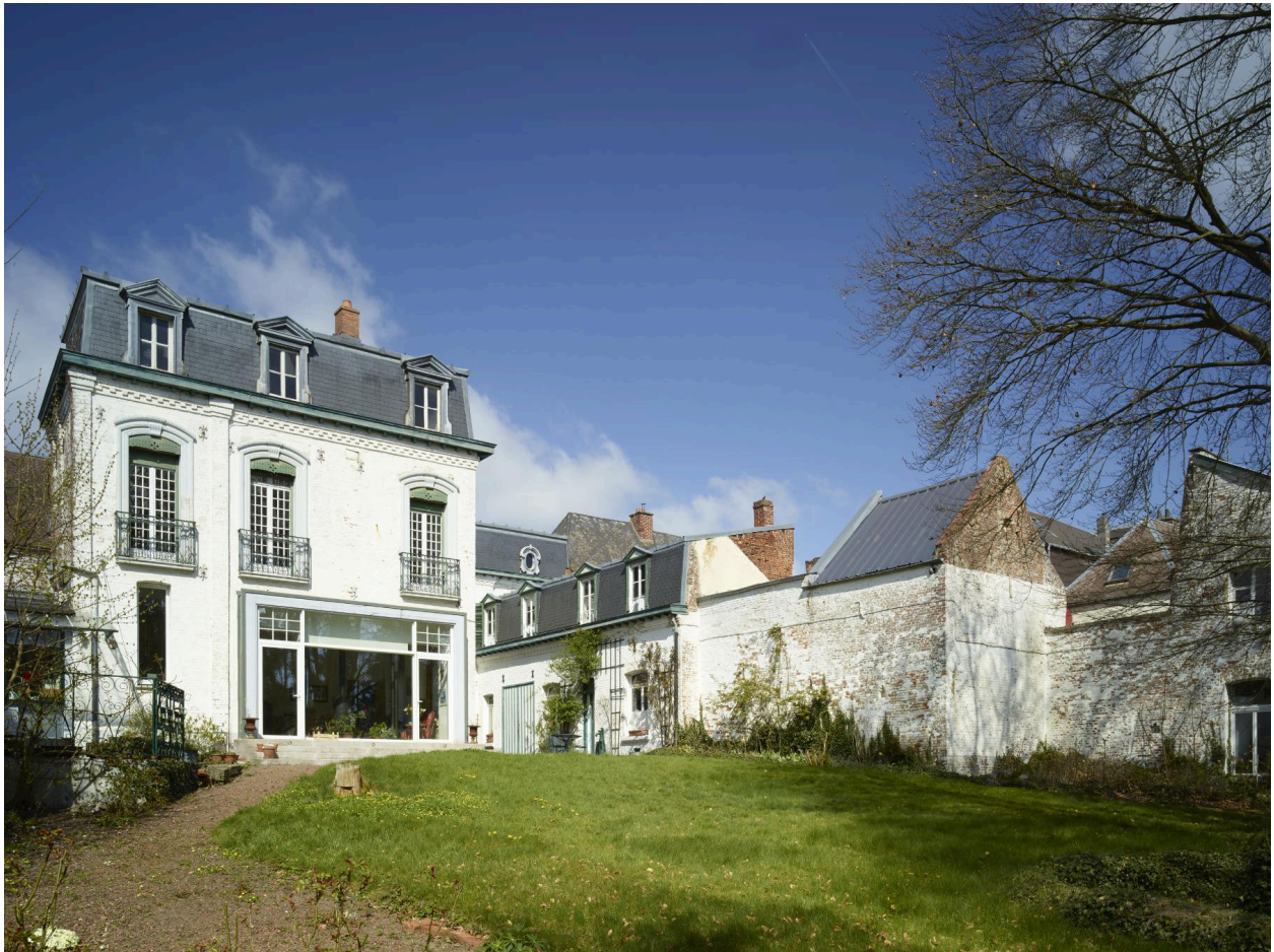
Vue générale de l'arrière de la maison depuis le jardin. Vue orientée nord-ouest/sud-est.
