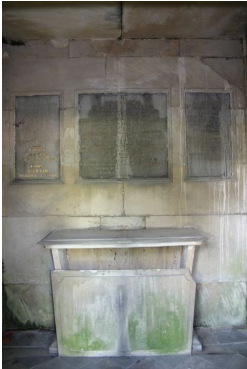
Vue intérieure du tombeau-chapelle, vers le faux-autel (D 32).
