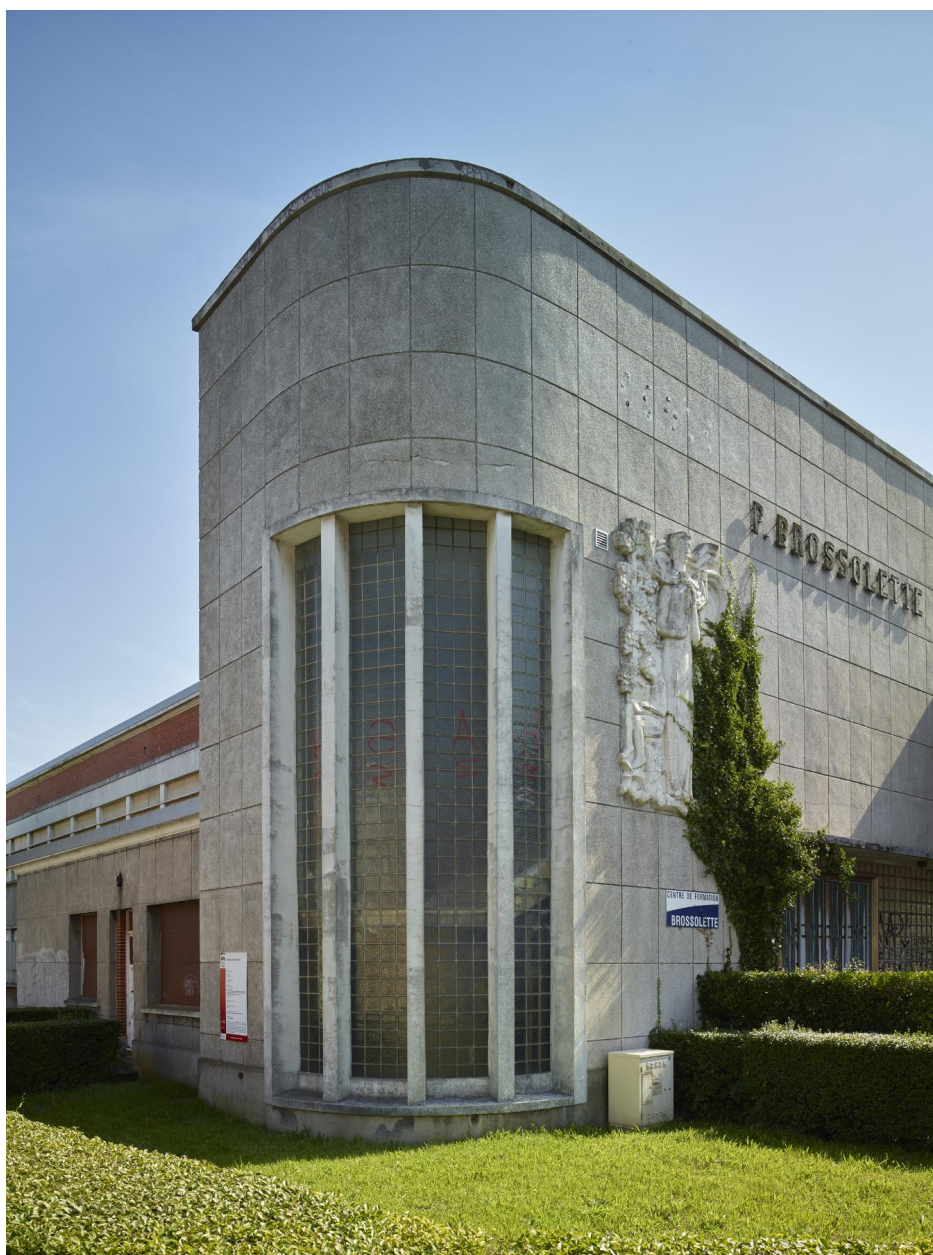
La cage d'escalier vers le sud-est, depuis la rue du Docteur Zamenhof.
