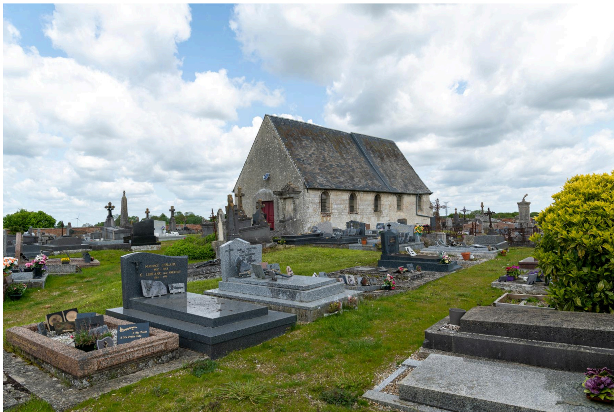
Vue générale du cimetière depuis l'angle sud-ouest.
