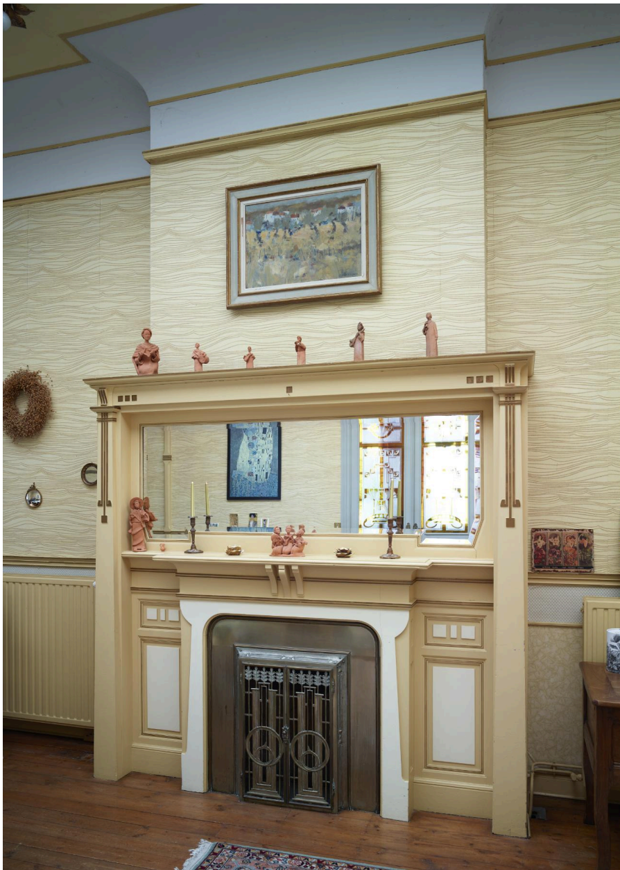
Cheminée engagée de la salle à manger.
