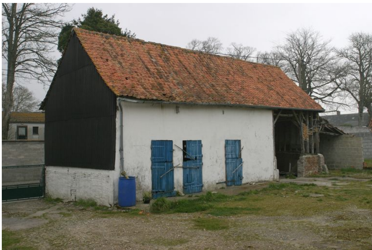
Vue des mêmes écuries depuis la cour.
