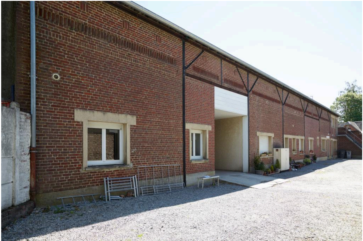
Vue de la façade sur cour de la grange à structure métallique fermant la seconde cour le long de la rue du faubourg de Péronne.
