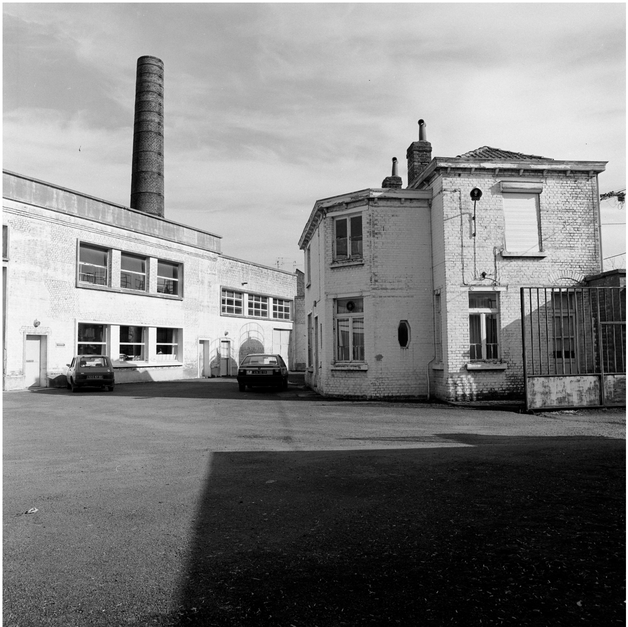
Bureaux. Vue prise depuis la cour.
