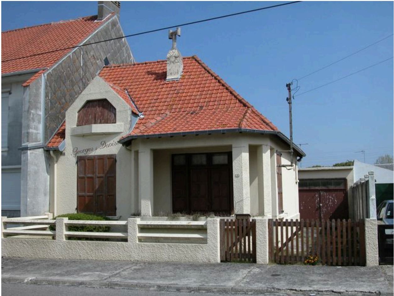
Maison construite en retrait de la rue (Georges et Denise, 58 rue Clémenceau).
