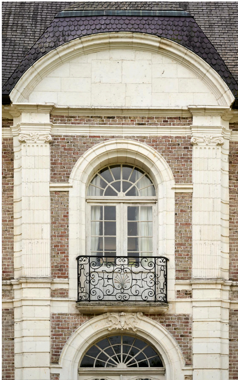
Détail du balcon de l'élévation nord.
