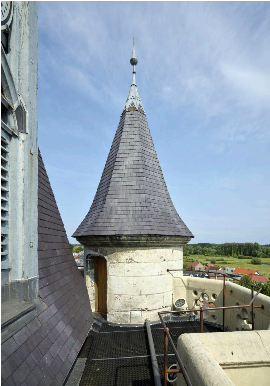
Sommet de la tourelle sud du beffroi.
