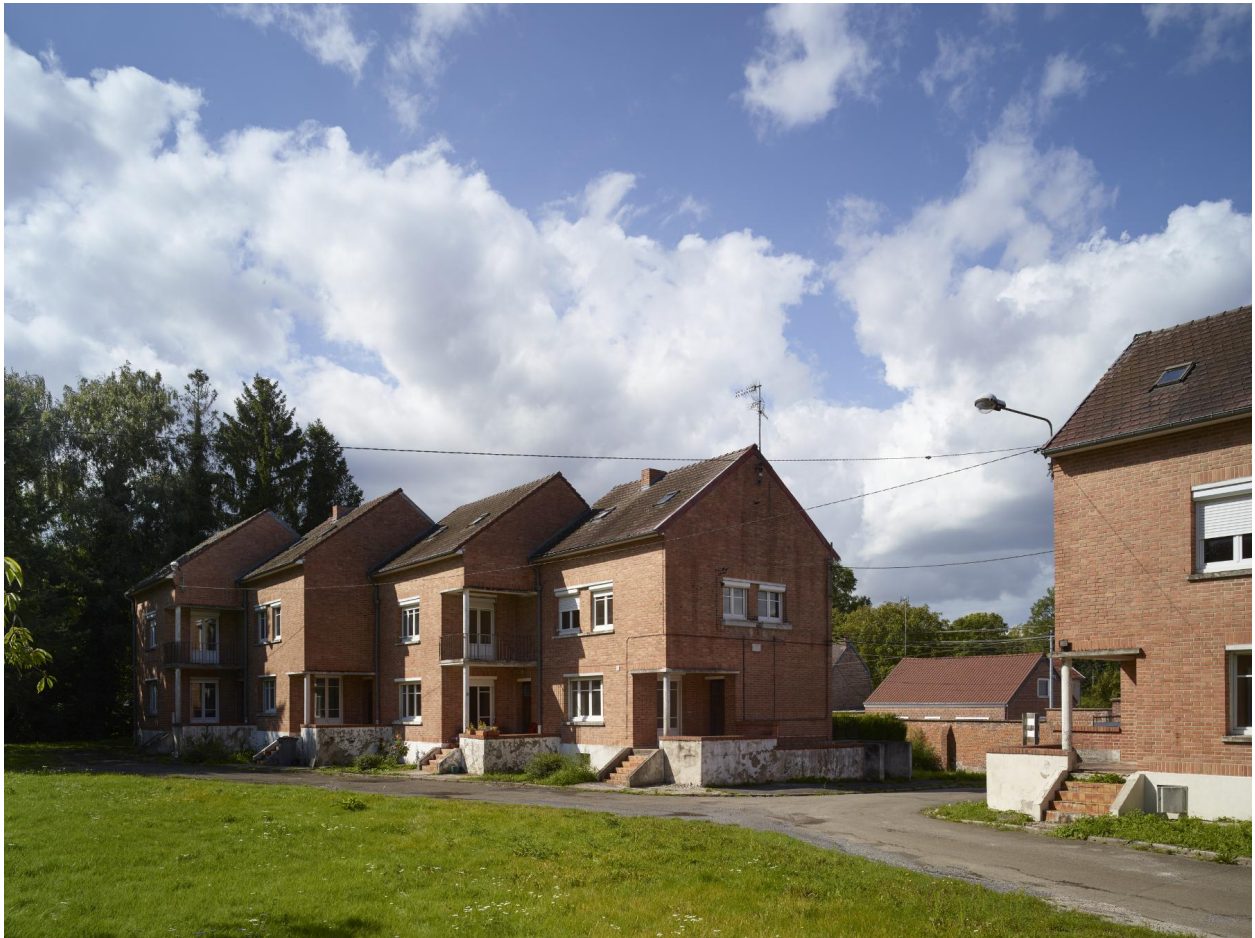
Ancienne gendarmerie : logements de fonctions construits dans les années 1950. Façades avant donnant sur le parc de la gendarmerie du bloc est, vue orientée ouest - est.
