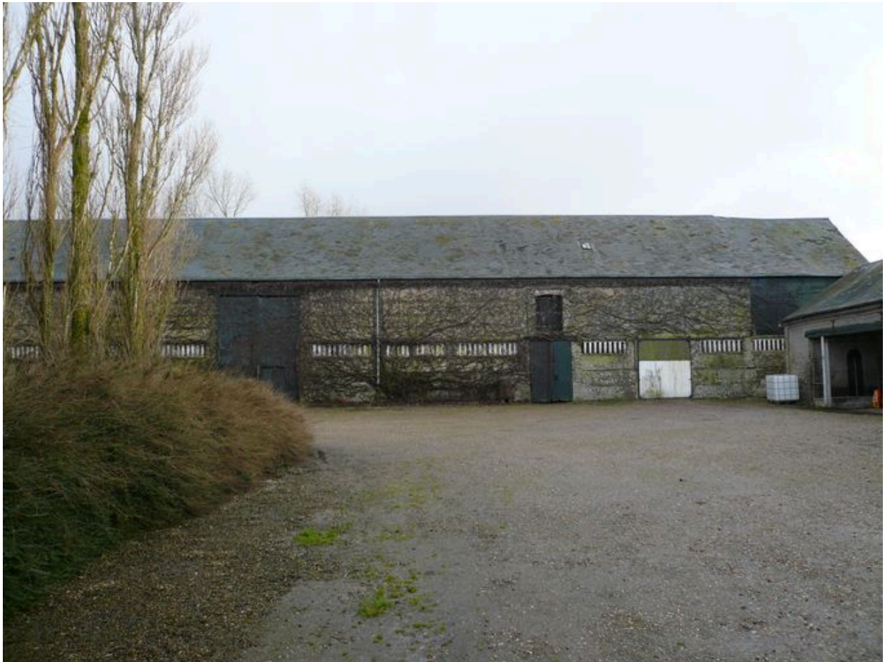
Vue de la grange au sud.
