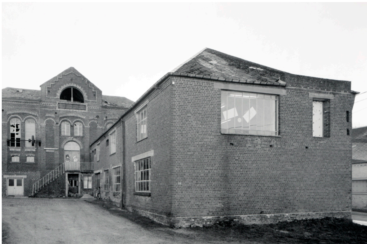
Vue générale de l'usine, depuis l'entrée.
