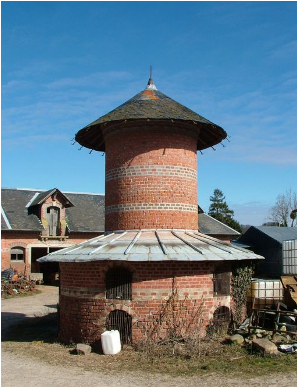
Ferme du château : colombier formant clapiers en soubassement.
