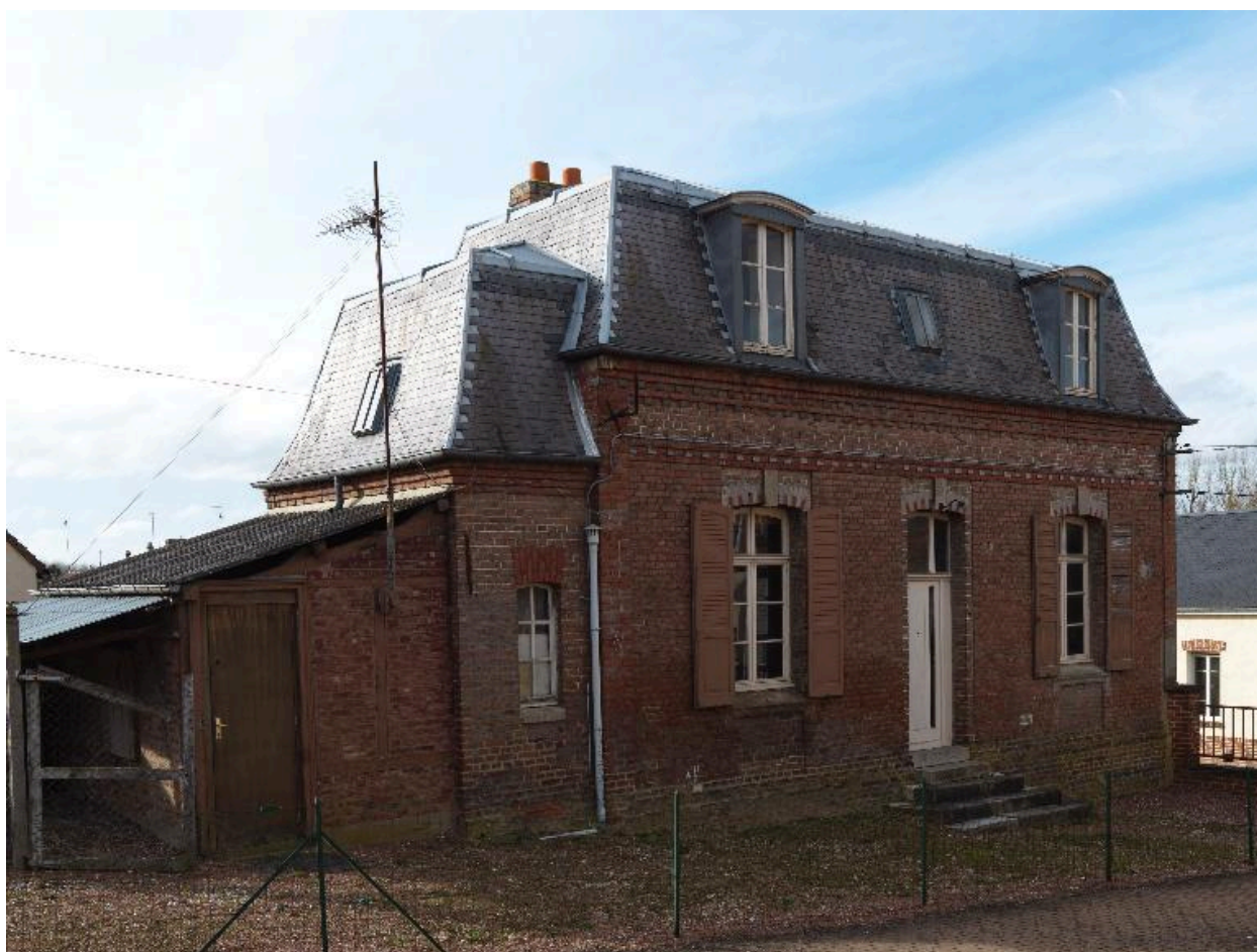
Vue d'un des logements.
