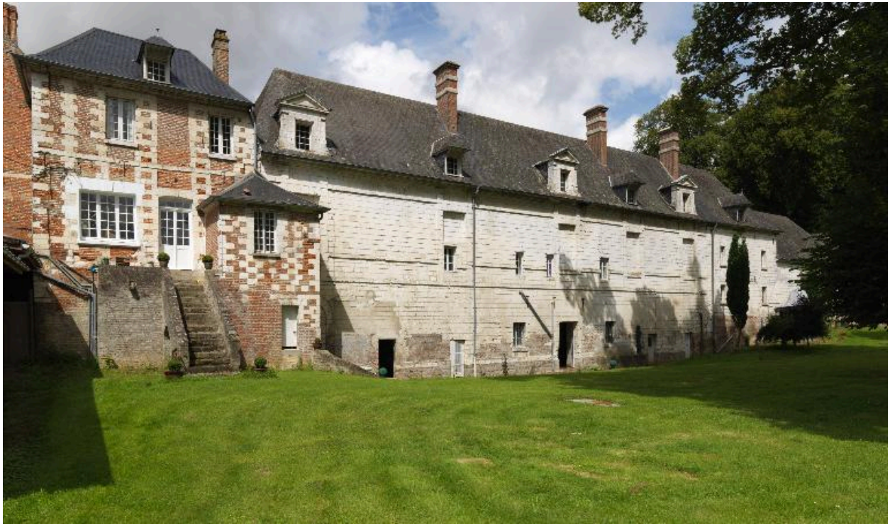
Élévations arrières du pavillon est du logis et de l'aile des communs sur la basse-cour.
