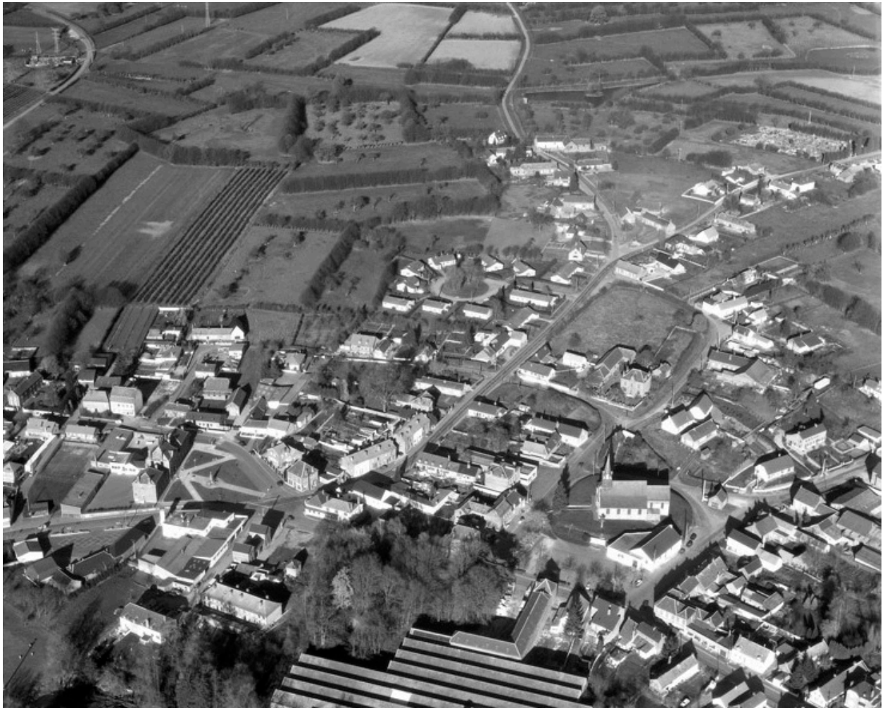
Vue aérienne de l'usine, depuis le sud-est.
