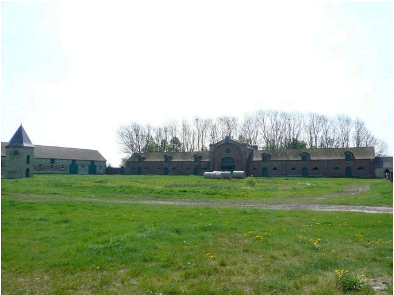
Vue des bâtiments au sud, les étables, la chapelle et le pigeonnier au centre de la cour.
