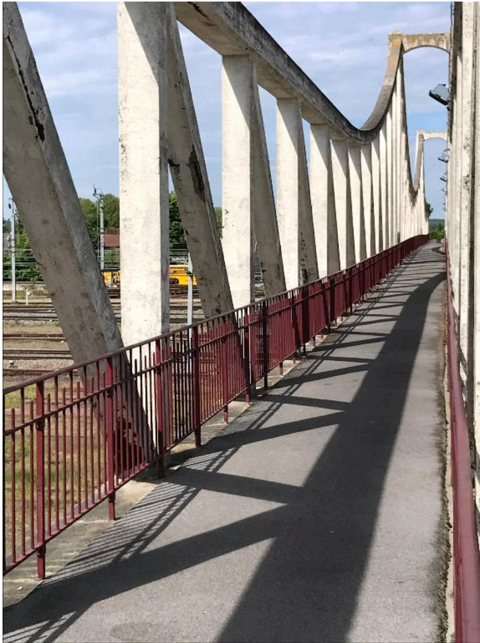
Vue générale de la passerelle.
