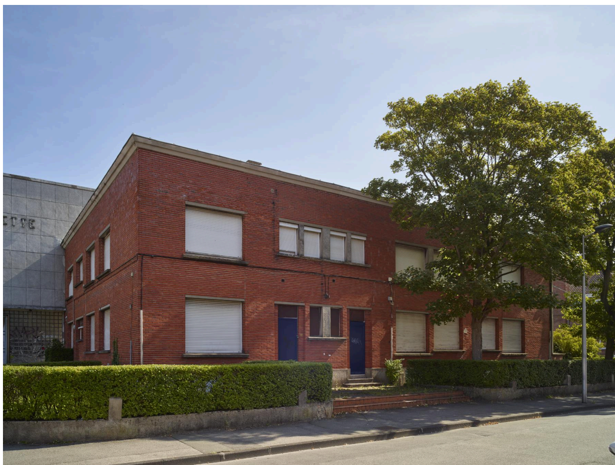
Logements de fonction, rue Georges-Claeyman.
