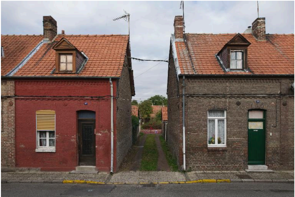
Passage entre deux blocs de logements ouvriers, rue Docteur-Jean-Martin (entre les n°65 et 67).
