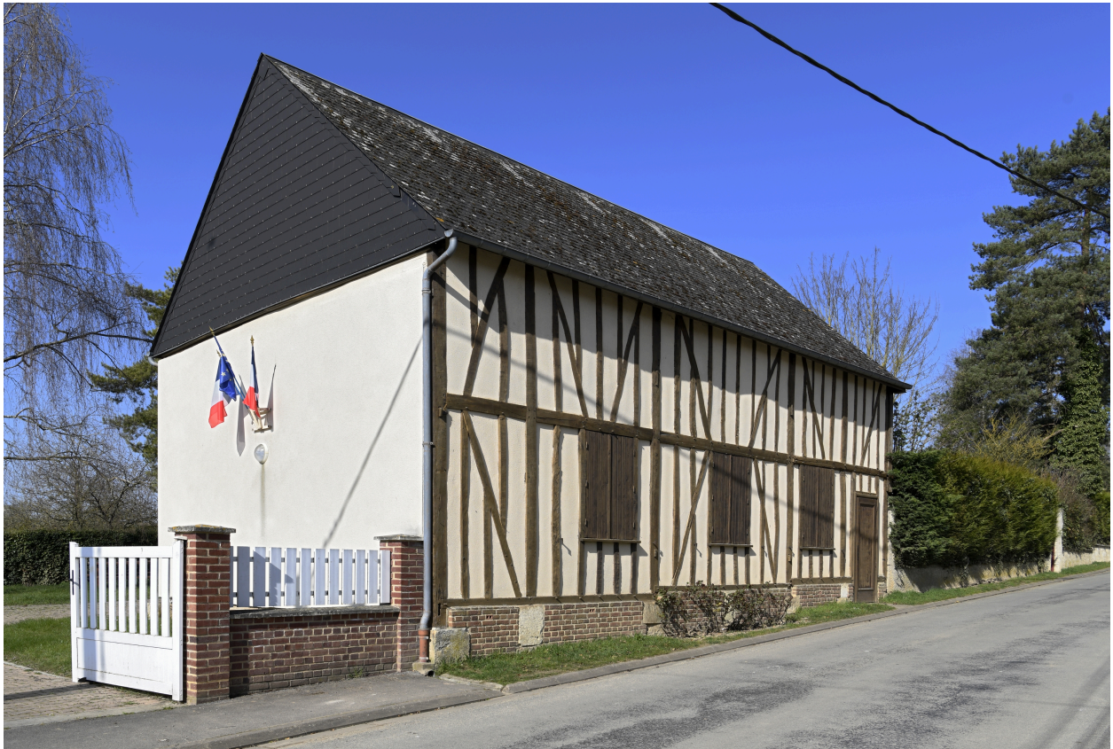
Ancienne grange (?) convertie en salle des fêtes, Petite Rue. Vue prise depuis l'est.
