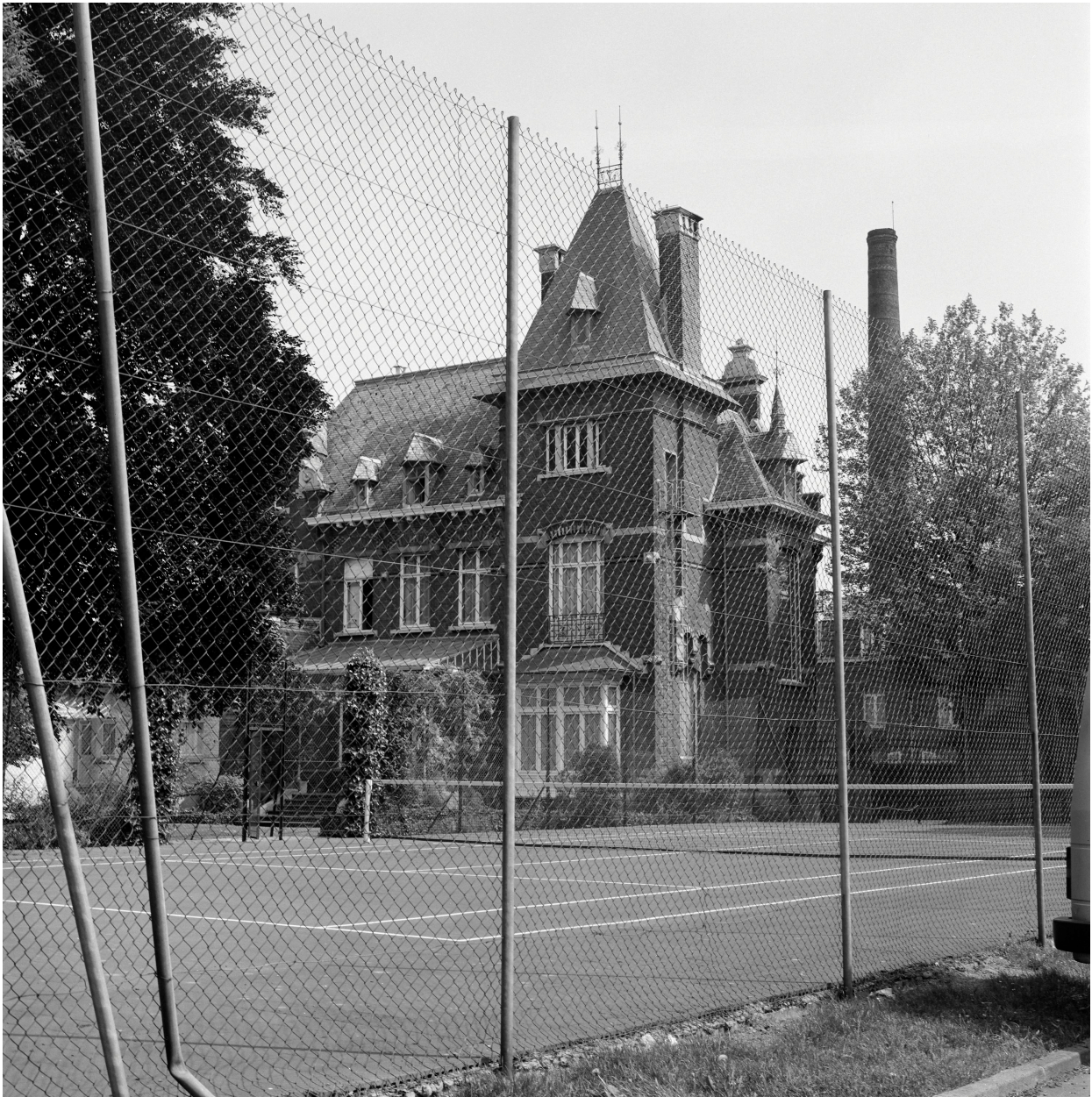
Logement patronal. Élévation postérieure.
