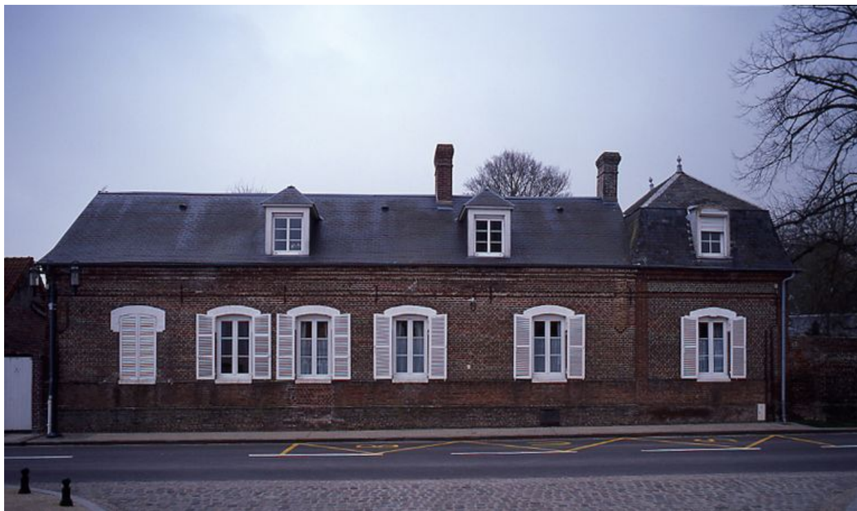
Vue du logis depuis la rue.
