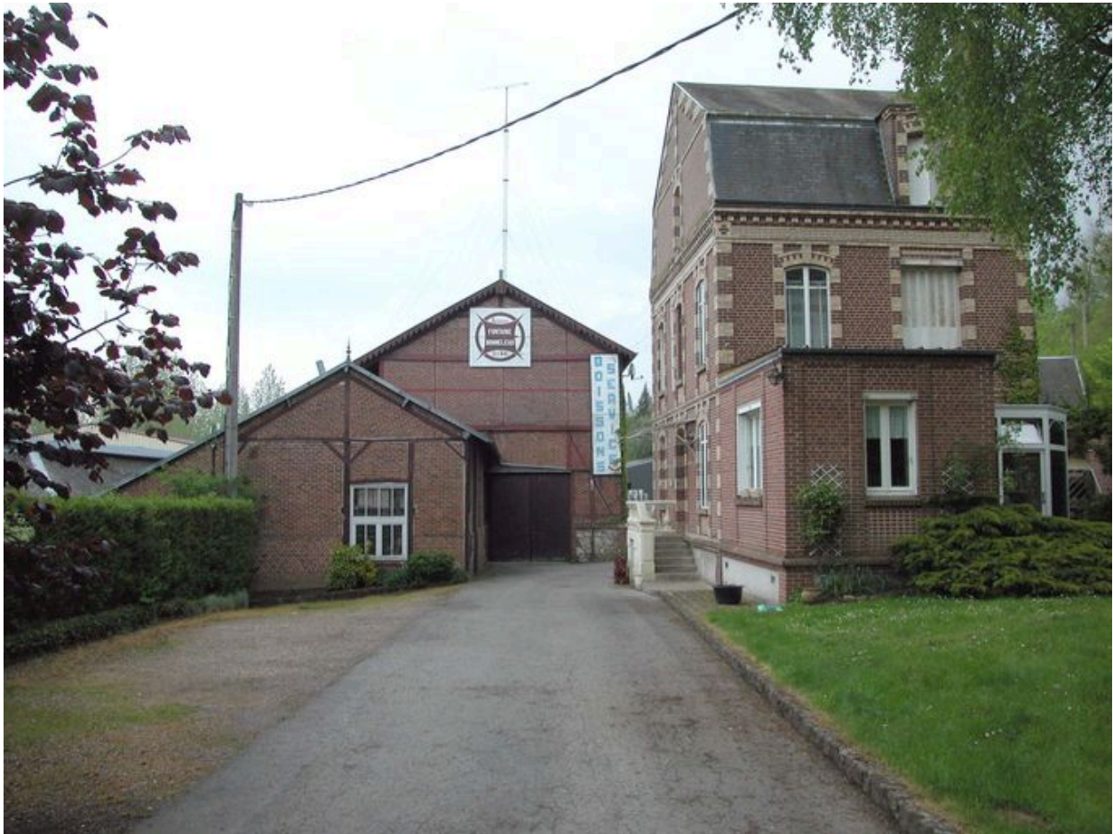
Vue d'ensemble depuis l'entrée de l'usine.
