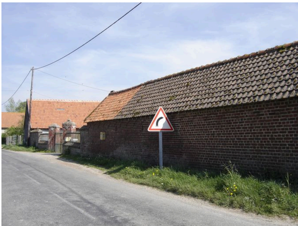
Vue d'ensemble depuis la rue du Hamelet.
