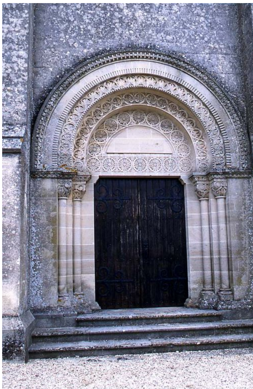
Vue détaillée du portail.
