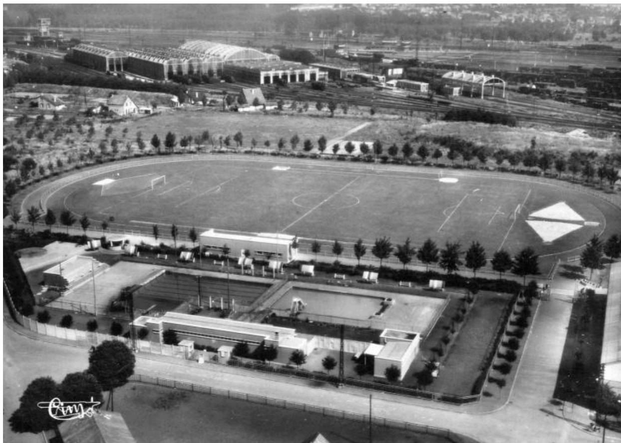
Vue aérienne des équipements sportifs de la cité des cheminots de Tergnier : la piscine et le stade avec terrain de football, carte postale, vers 1950 (coll. part.).
