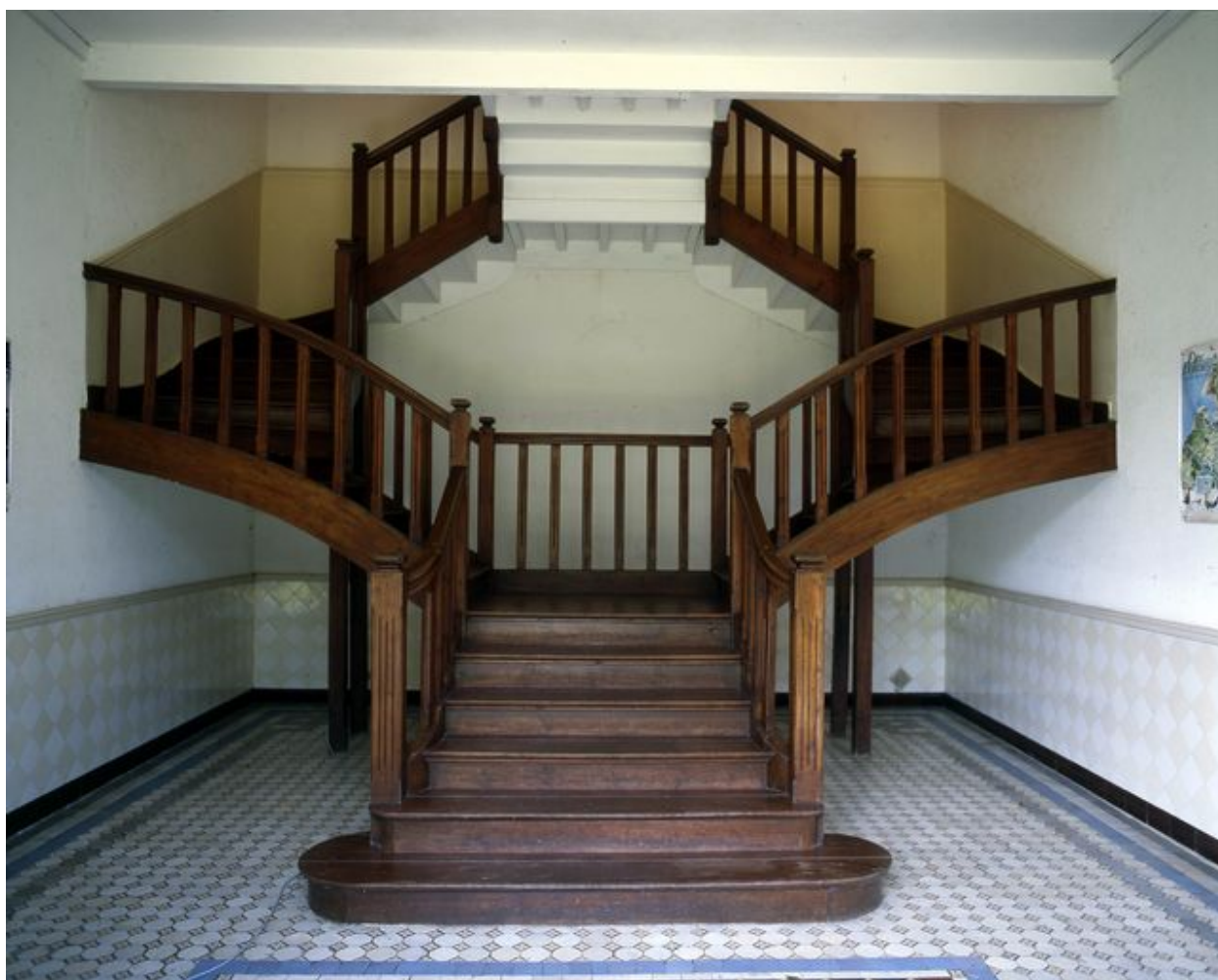
Vue de l'escalier intérieur en charpente.
