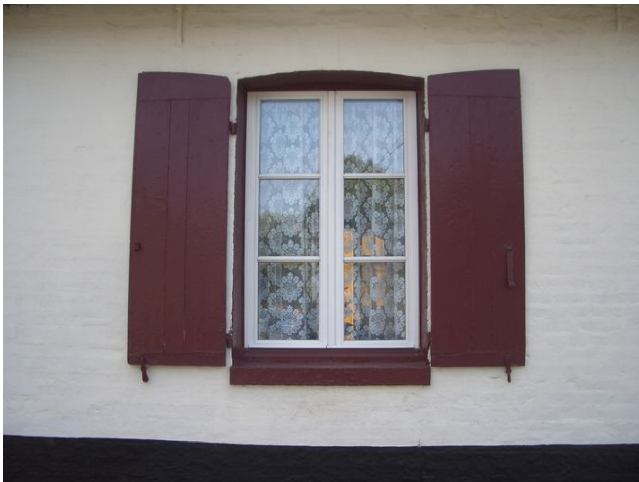
Vue détaillée d'un autre contrevent.
