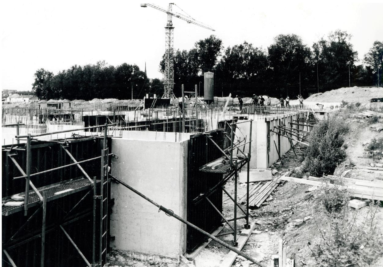
Amiens. Parc de Beauvillé. Mise en œuvre de la construction en béton banché, photographie noir et blanc, [vers 1970] (AC Amiens ; 6Fi 902).
